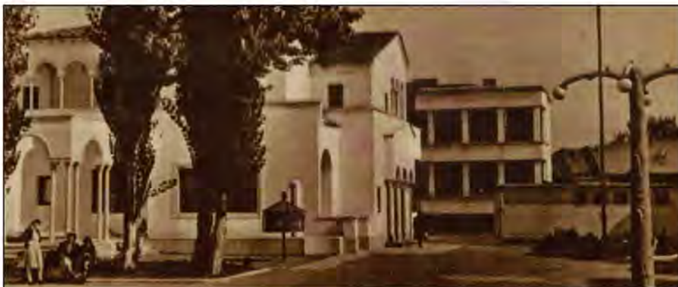
1968. Ploiești. Casa pionierilor.
